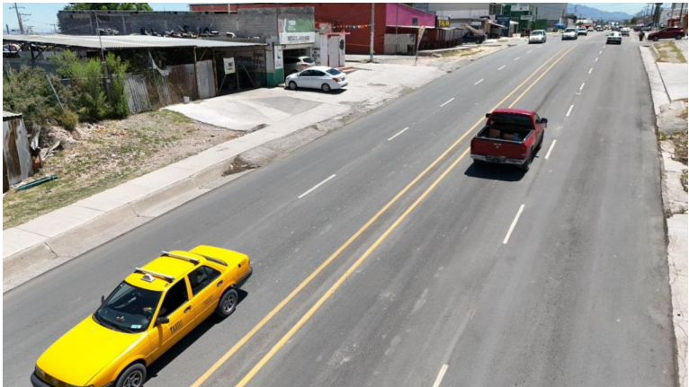
EL DIRECTOR DE Infraestructura y Obra Pública, Antonio Nerio Maltos, dio a conocer que la repavimentación entregada comprende el tramo entre las calles Mármol y San José, con una longitud de 702 metros lineales.
