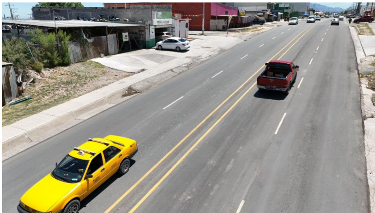
EL DIRECTOR DE Infraestructura y Obra Pública, Antonio Nerio Maltos, dio a conocer que la repavimentación entregada comprende el tramo entre las calles Mármol y San José, con una longitud de 702 metros lineales.
